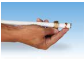
Inserte el casquillo en la tubería
