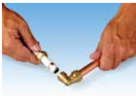
Asegúrese de que la tubería esté totalmente insertada
