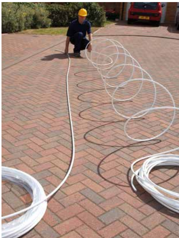
Fig.4: La tubería Hep 2 O (izquierda) sale recta del rollo
