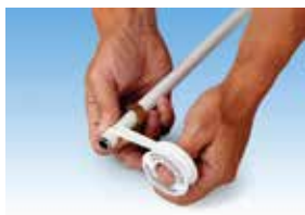
Coloque cinta de teflón si es necesario
