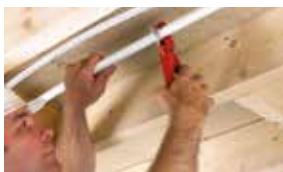
Medición y corte in situ
