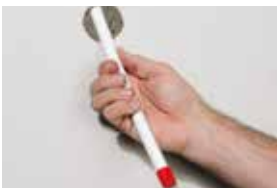
Fig. 22 Proteja siempre los extremos de la tubería
